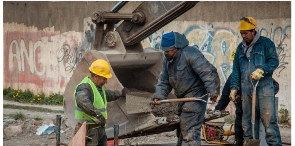
En los días previos se realizó el armado del encabezado de dos de las tres alcantarillas aguas abajo del puente y posteriormente se realizó el encofrado. Con ese trabajo terminado se vertieron siete 7 metros cúbicos de hormigón en el encabezado.
