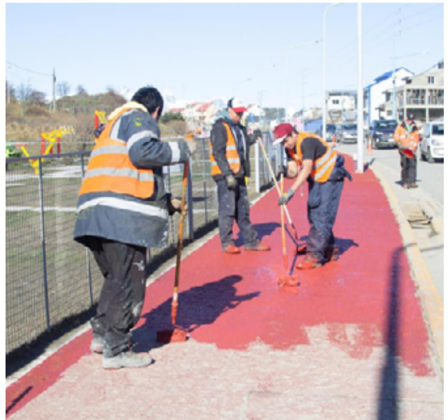
técnica de pintura en caliente que fija el dibujo de las sendas peatonales en las aceras.
